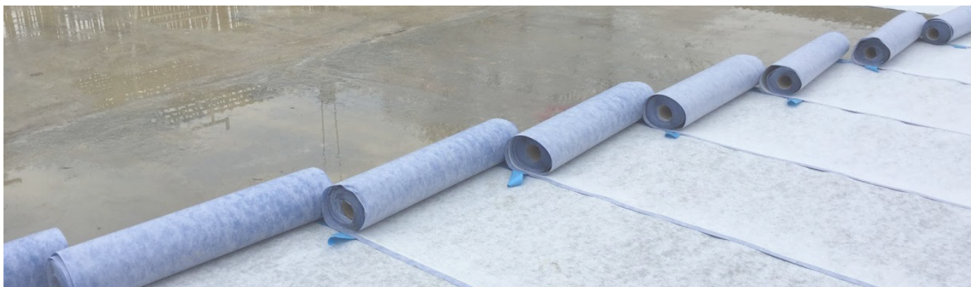
Udlægning af Polyfleece SX® 1000 Wall under bundplade inden støbning. 1x20 m.
