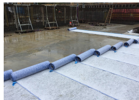
Udlægning af Polyfleece under bundplade inden støbning. 1x20 m.
