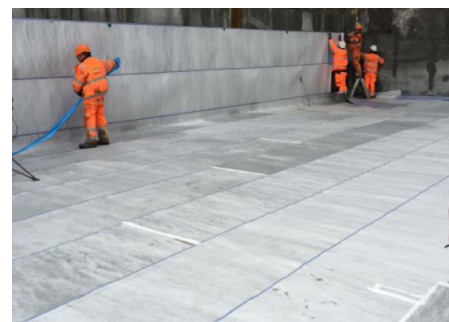
Montage af Polyfleece - både på væg og bundplade.
