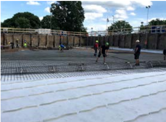
Metro Nordhaven CRNH 1+2 Bygherre: Metroselskabet I/S Bygherrerådgiver: Rambøll Arup Joint Venture Totalentreprenør: MetNord JV I/S (Züblin & Hochtief) ca. 21.700 m 2 polyfleece
