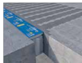
Recessen efterfyldes med mørtel og skal derefter hærde.
