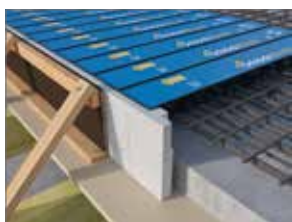
Indsættelse af ende- og receselementet i armeringen.
